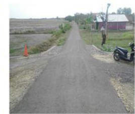
Peningkatan Akses Jalan
