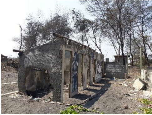
Gambar 11. Bangunan yang Rusak Akibat Adanya Empasan Gelombang di Segmen Pantai Dengan Kelas Kerawanan Sangat Tinggi
