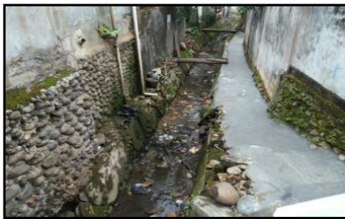
Gambar 8. Kondisi Drainase yang dibangun rumah di sepanjang drainase
