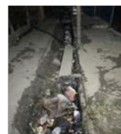
Gambar 6. Kondisi drainase yang tertutup oleh sampah, kondisi drainase masih baik.
