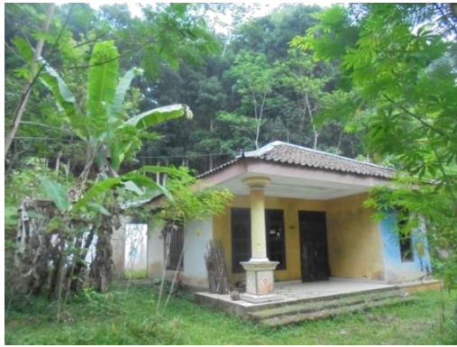
Gambar 2. Rumah warga yang bagian belakangnya terkena longsor, tidak dihuni. Penghuninya sudah direlokasi Sumber: Dokumentasi C.Yudi, 2018
