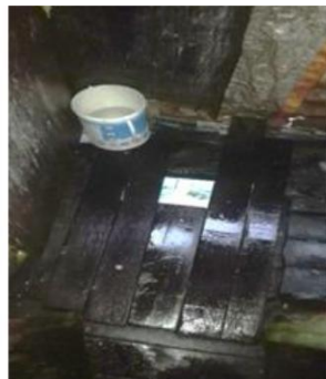
Gambar 10. Kondisi jamban yang langsung berada diatas sungai dan merusak lingkungan khususnya air sungai
