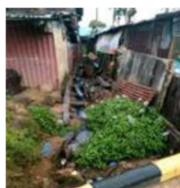
Gambar 5. Kondisi drainase yang tertutup oleh rumput dan papan, kondisi drainase rusak
