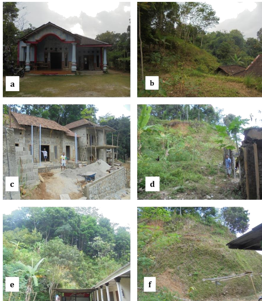
Gambar 3. (a) Salah satu rumah warga yang sudah relokasi di Dukuh Buntung, Gerdu, Karangpandan, Karanganyar; (b) Rumah warga dibawah bukit, di relokasi. Rumahnya yang baru sedang dibangun Pembangunan rumah warga ditempat baru (relokasi), posisi diatas rumah lama; (c) Pembangunan rumah warga ditempat baru (relokasi), posisi diatas rumah lama; (d) Bukit dibelakang sisa bangunan rumah yang terkena longsor 2012, sudah mulai turun atau bergerak ke bawah, tanda akan terjadinya longsor kembali, sehingga direlokasi; (e) Rumah warga yang terkena longsor 2012 sekarang hanya dibersihkan dan tidak ditempati, takut kelongsoran; (f) Bukit yang bergerak kebawah, berada tepat di depan rumah warga Buntung yang setiap saat dapat longsor. Rumah relokasi sedang dibangun
