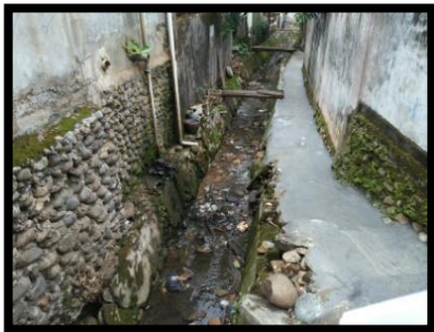
Gambar 4. Kondisi Drainase Sumber : Dokumen NUAP (2016)
