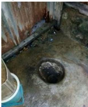
Gambar 9. Kondisi jamban yang tidak memiliki septic tank , minim air bersih dan pencahayaan yang kurang.
