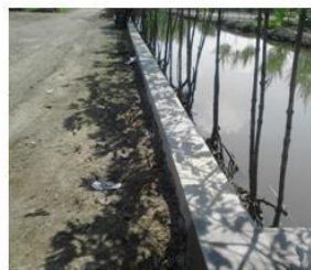
Pembuatan Talud Pengaman Jalan
