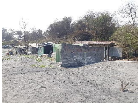
Gambar 10. Bangunan yang Rusak Akibat Adanya Empasan Gelombang
