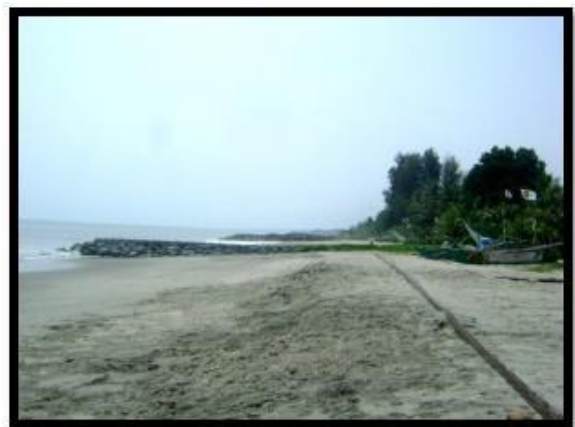
Gambar 6. Pengaman Pantai Berupa Grib dan Vegetasi untuk menanggulangi abrasi di Desa Ampalu (Sumber : Dokumentasi Lapangan, 2015)
